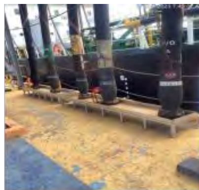
ภาพที่ 11 ถาดรองน้ำมันที่อาจรั่วหกและวาล์วที่ปิดกั้นน้ำมันปิดตลอดเวลาการขนถ่ายน้ำมันที่ท่า
